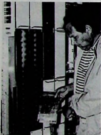
Bild 1: Spleißaufnahme mit 10 Spleißen des Glasfaserkabels für die Fernstrecke (PKI/F & G-Pressbild)
